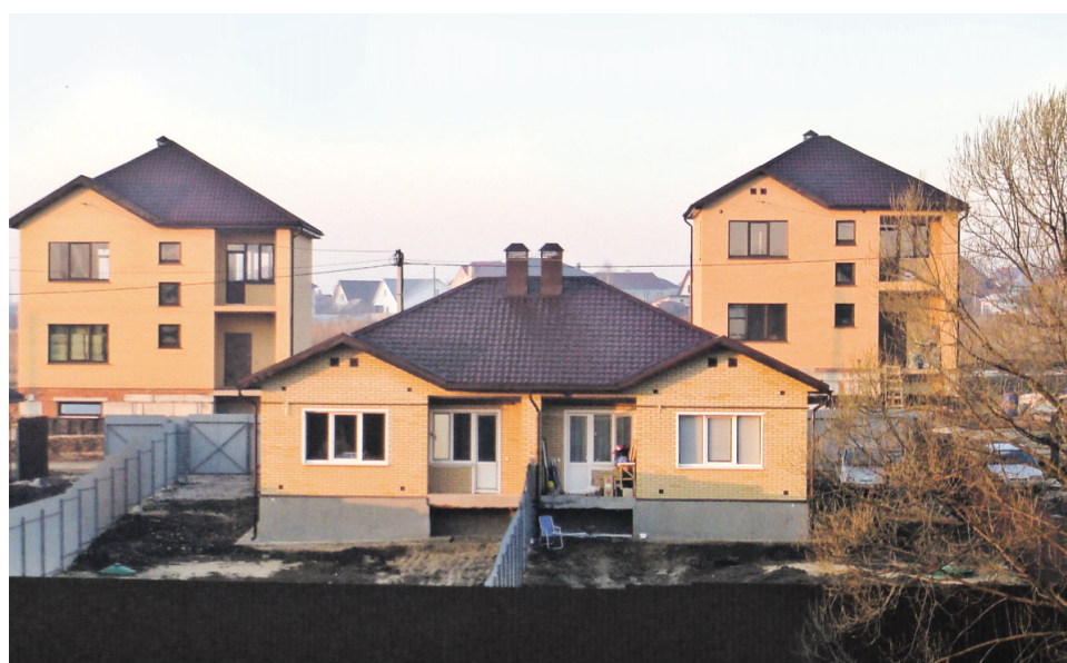
▲ В основе таких домов лежит каркас из легких стальных профилей
