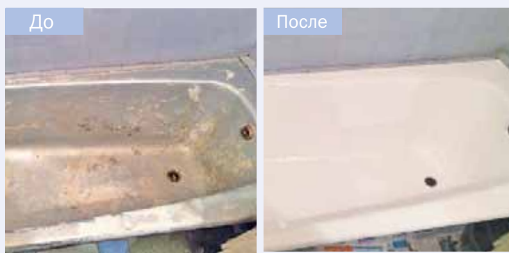
▲ Результат до и после применения жидкого акрила
